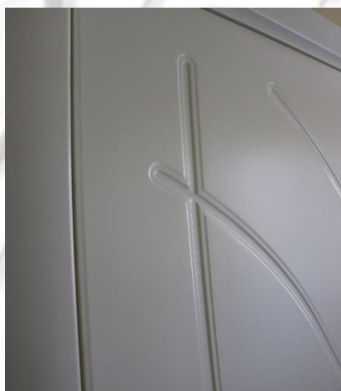
Obloge vratnog krila MDF debljine 6 mm (duboka kanalura)
